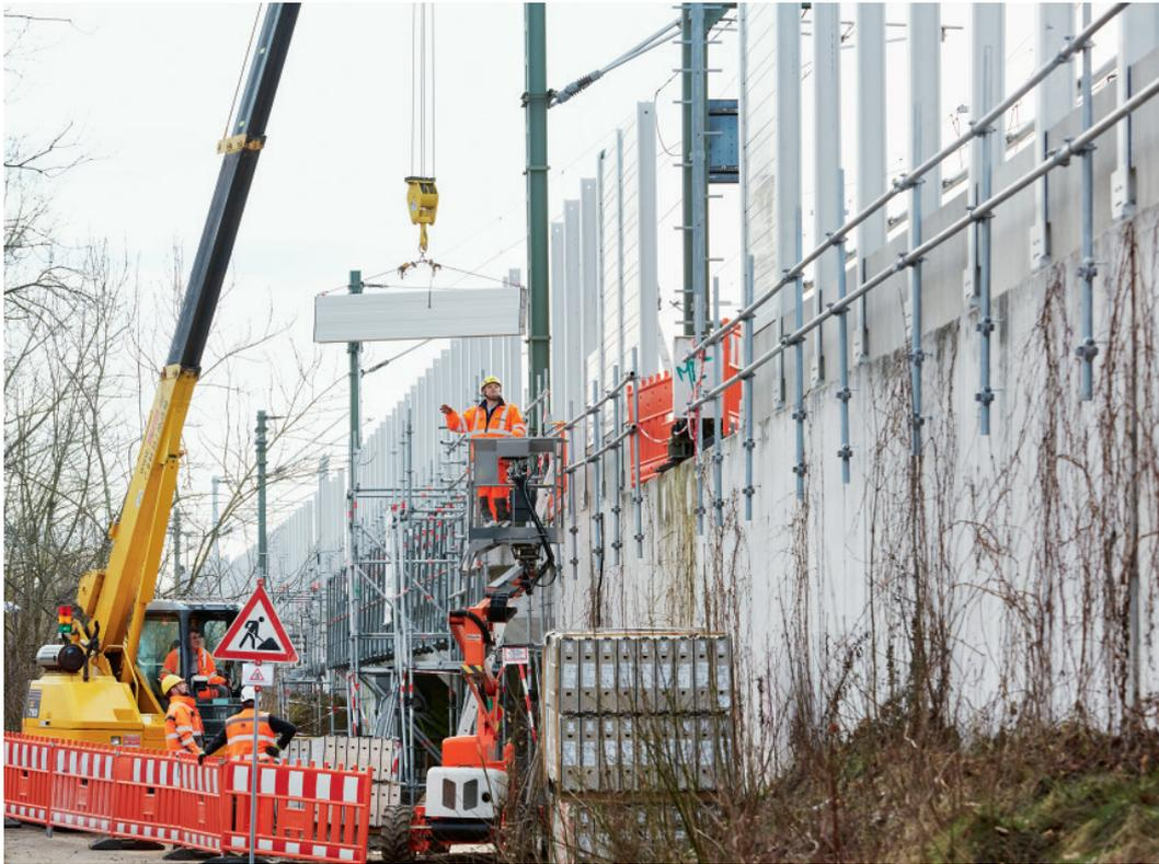
Abb. 2: Montage der Lärm-schutzwand mit einem Ketten-kran auf einer Stützmauer
